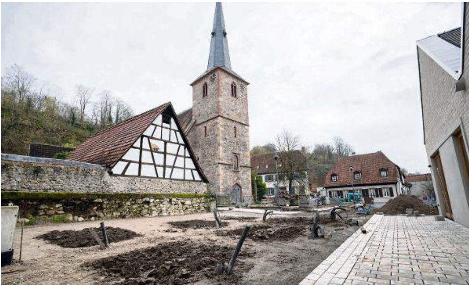
Der Platz hinter dem neuen evangelischen Gemeindehaus ist nun aufgefüllt und für die Pflasterung vorbereitet. Bild: Marco Schilling
